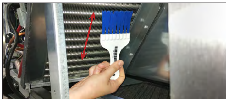
Fig. 3. Ne brossez jamais en travers des ailettes du serpentín.
