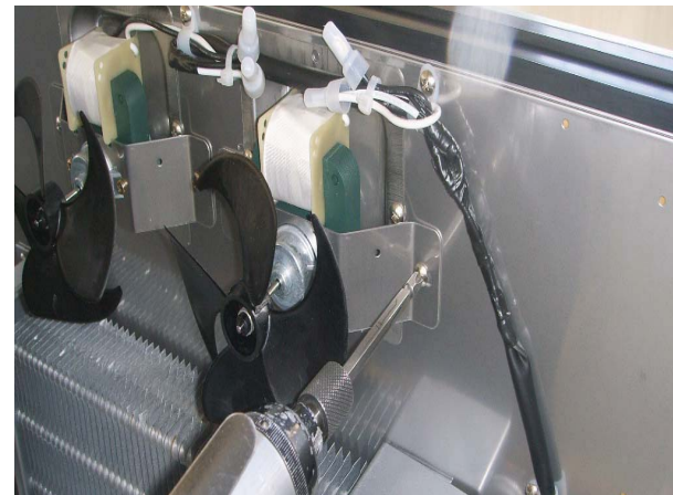
B. Remove the evaporator fan motor
