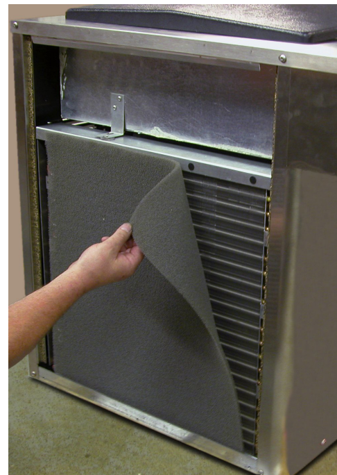
Fig. 3-11 Retiro del filtro condensador, modelo F112
