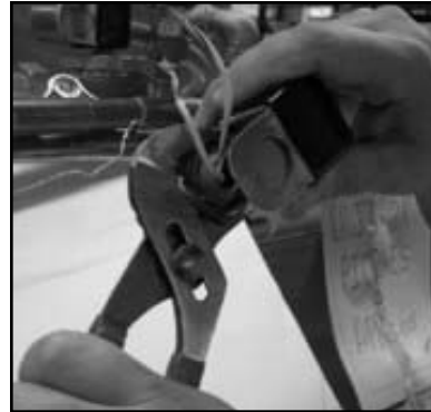
Loosening the conduit nut
