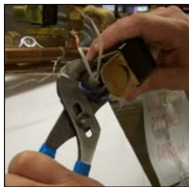
Loosening the conduit nut
