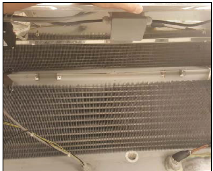
Fig. 14 Fan and Fan Plenum
