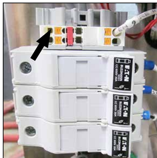
Fig. 22- Vent fan signal connection
